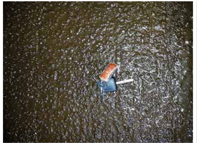
Figura 5: Detalhe após aplicação da 2ª camada. (23/06/15 – 0h23)
