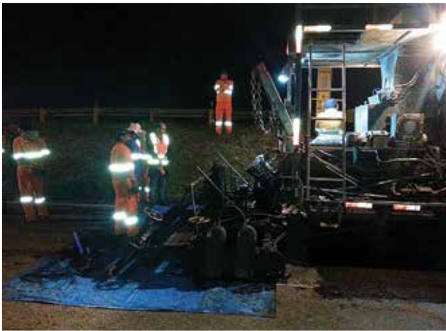
Figura 4: Início da aplicação da 2ª camada. (23/06/15 – 0h12)
