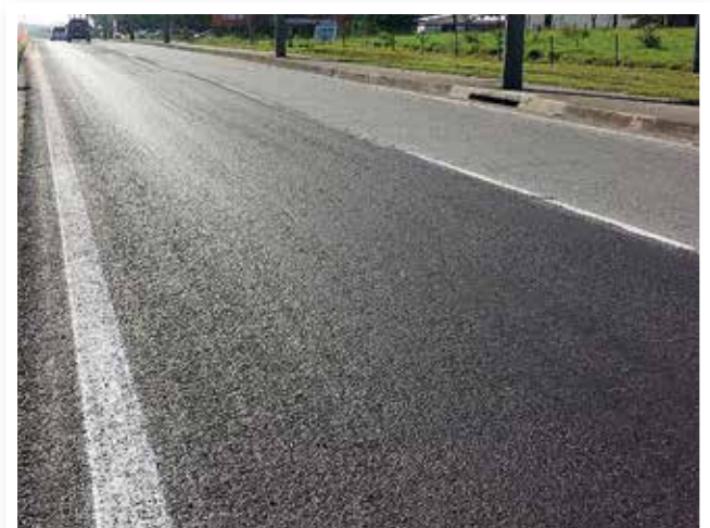
Figura 7: Detalhe da liberação ao trânsito após 4 horas. (23/06/15 – 10h26)
