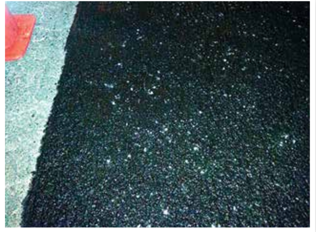
Figura 3: Detalhe da 1ª camada após rolagem. (23/06/15 – 0h05)
