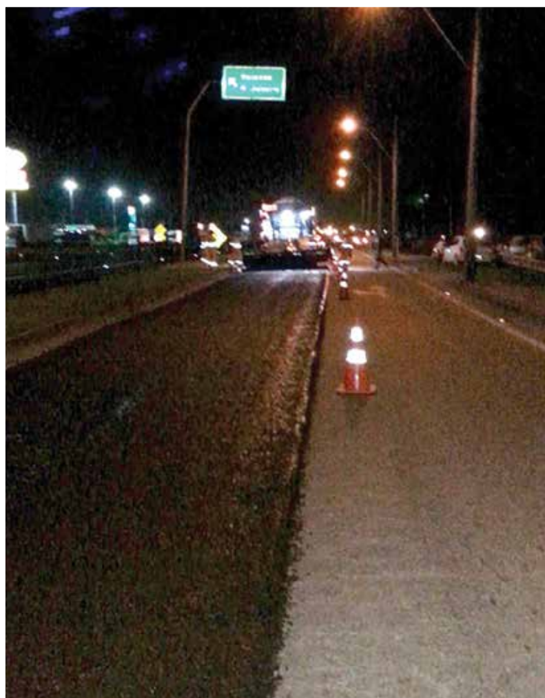
Figura 1: Detalhe da aplicação 1ª camada. (22/06/15 – 23h57)
