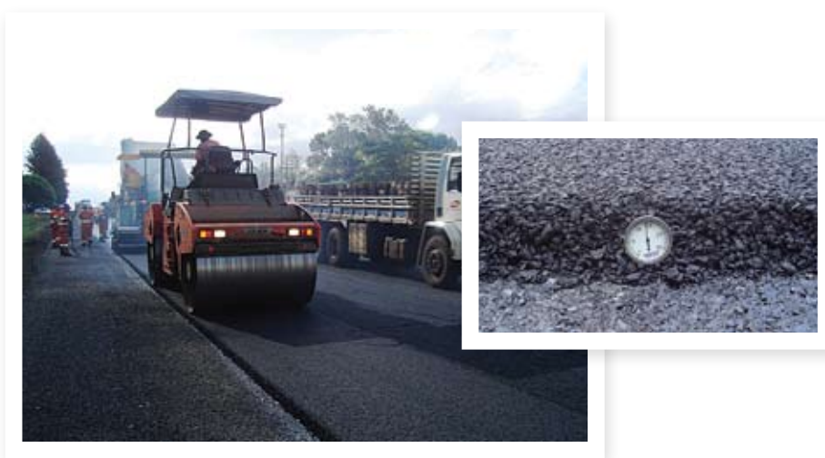
Figura 3. Aplicação e compactação do GAP GRADED com ECOFLEXPAVE B-3G.
