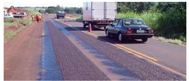
Figura 5 - Antes: pintura de Ligação com RR-1C-EP. Depois: trilhas de rodas preenchidas pelo MRAF.
