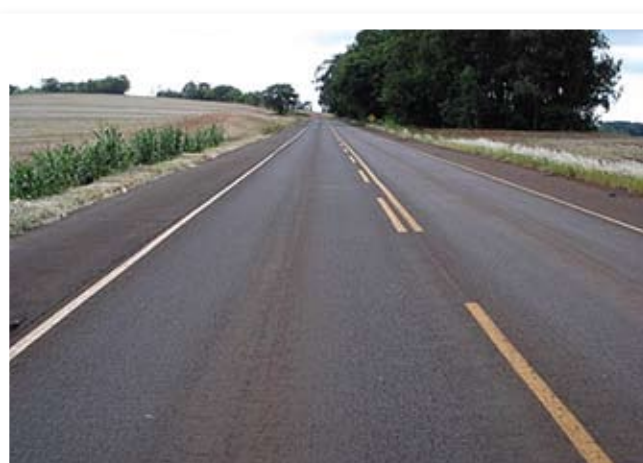
Figura 8 - Condições gerais de trechos da rodovia recuperada – 1 ano após a aplicação.
