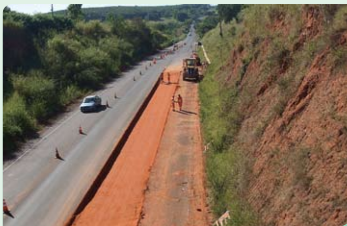
Remoção pavimento.
