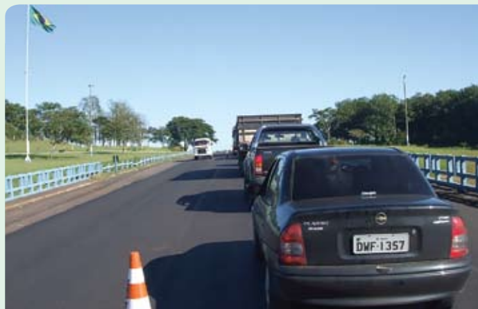
Novo pavimento reciclado e aprimorado com GRECAFLEX
