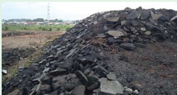
Capa do pavimento descartada em aterro.
