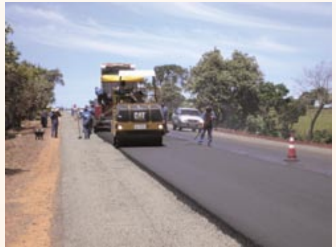
Detalhe da aplicação da massa asfáltica com GRECAFLEX na SP/255
