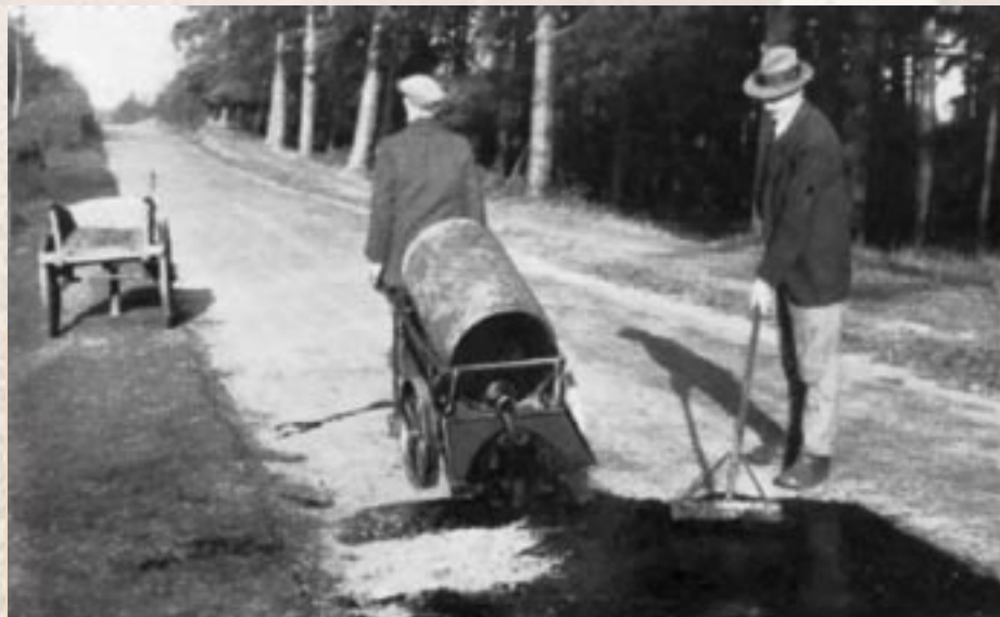
Aplicação de emulsão asfáltica no início do século XX
