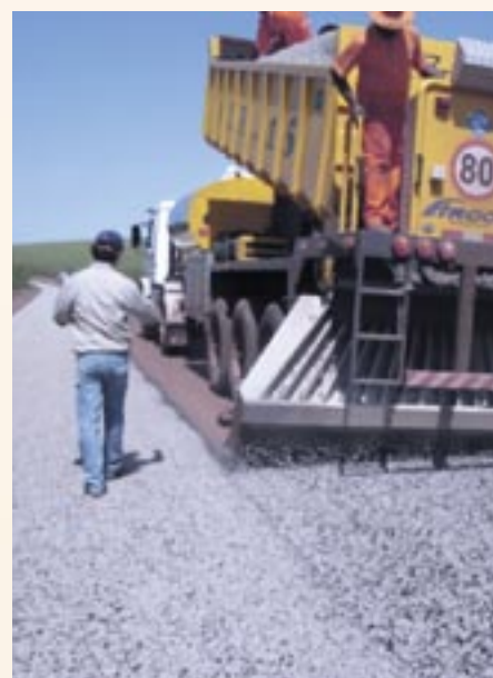
Aplicação da 1ª Camada – RR-2C e Brita 3/4
