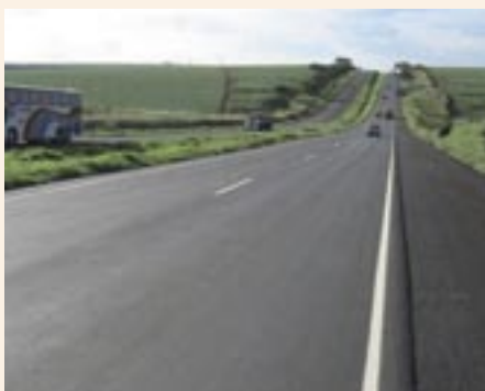
Detalhe do pavimento executado com Asfalto Borracha sob avaliação
