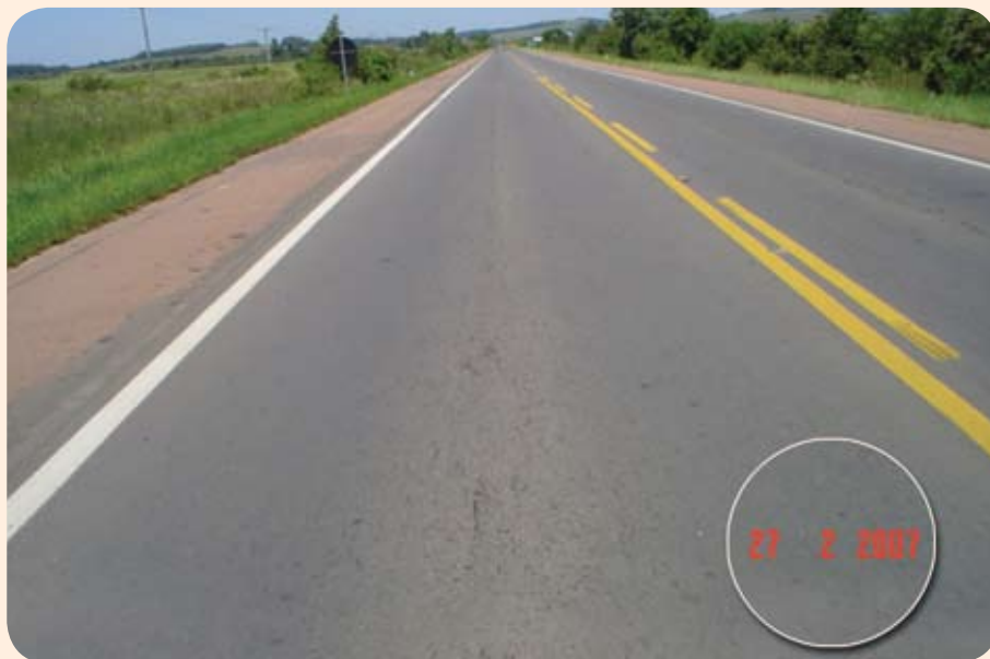
Figura 1 - Vista geral do trecho pioneiro de Asfalto Borracha em fevereiro de 2007
