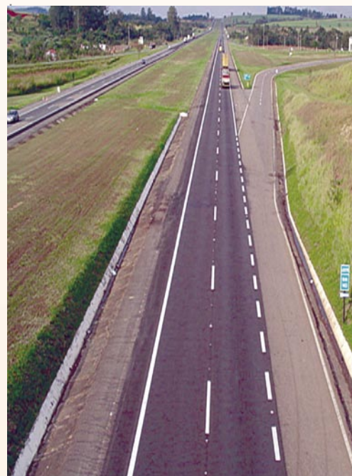
Aparência do trecho executado em Tatuí
